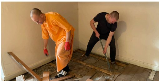
v.l. Siksastakam Prabhu und Manu Prabhu bei Renovationsarbeiten
